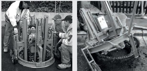
Die umliegende Asphaltdecke wird ebenfalls leicht mit angehoben, wodurch es im Laufe der Zeit zur Absenkung und Lockerung der Asphaltdecke kommt.
